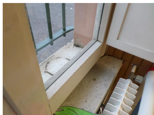
Figura 4.4 - Particolare dei serramenti
