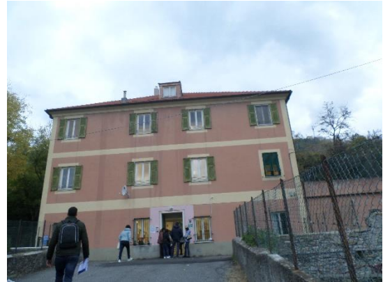
Figura 1.1 - Vista della facciata esposta a sud
