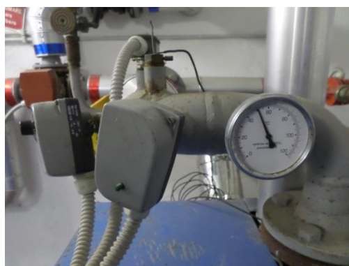
Figura 4.7 – Sonda Temperatura ritorno centrale
